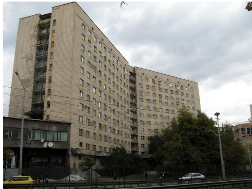
м. Київ, вул. Борщагівська, 146
